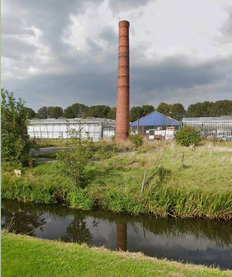
Tuinderschoorsteen - Korenmolenweg - Bleiswijk Aanleiding voor een openbare groene zone
