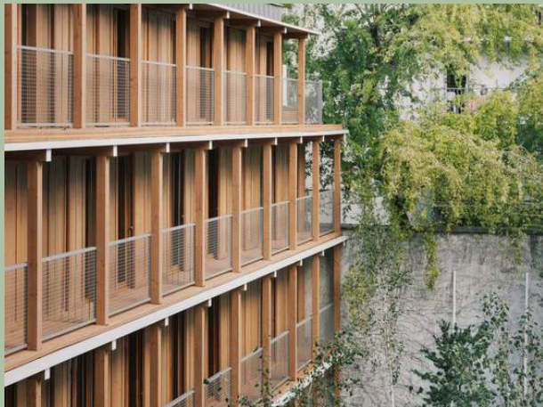
14 logementes - Parijs - MARS architectes
